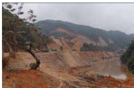
Ảnh 44: Cảnh quan công trường thi công nhà máy thủy điện Hồi Xuân (Ảnh Khu BTTN Pù Luông)
