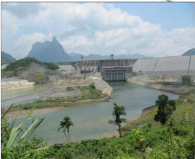
Đập thủy điện
