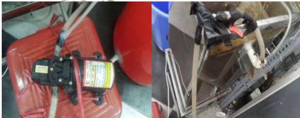
Hình 3.3. Bơm nước thải đầu vào
