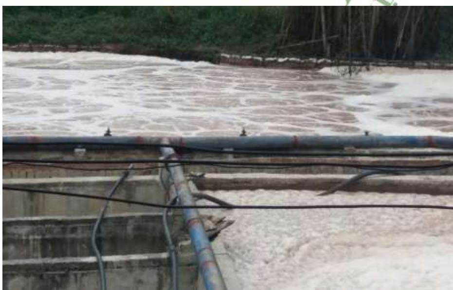
Hình 3.7. Bể Aerotank nhà máy XLNT Công ty CP TMSX địa Nguyễn Hồng
